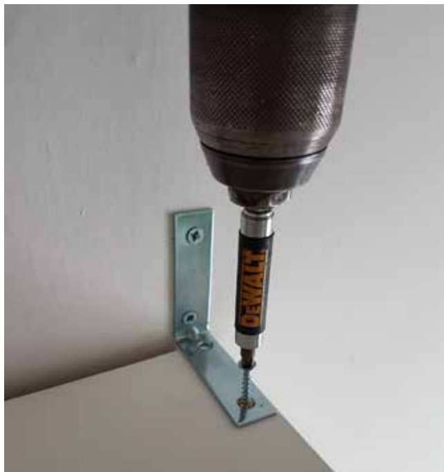
اتصال قفسه به دیوار با استفاده از پایه‌های «L» شکل
